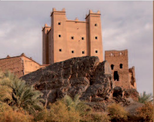
Kasbah Ait Hammou Ou Said, réhabilitée et transformée en école Medersat.com par la Fondation BMCE BANK
