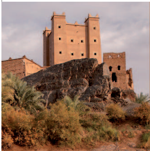
Kasbah Ait Hammou Ou Said, réhabilitée et transformée en école Medersat.com par la Fondation BMCE BANK
