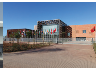
PLATEFORME DE RECHERCHE GREEN ENERGY PARK - IRESEN
