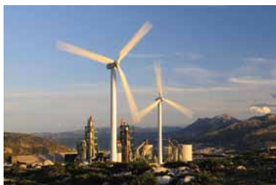
Usine et parc éolien de Tétouan
