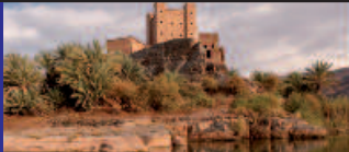
Kasbah Ait Hammou Ou Said, réhabilitée et transformée en école Medersat.com par la Fondation BMCE BANK
