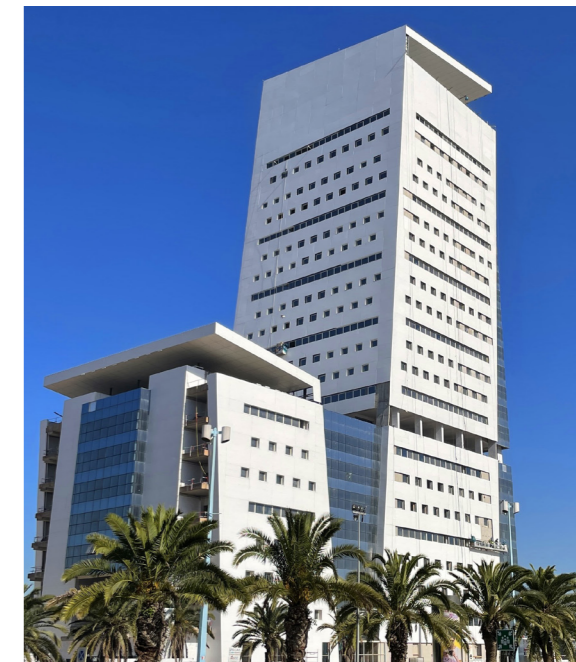
Le béton au centre des façades design et durables
