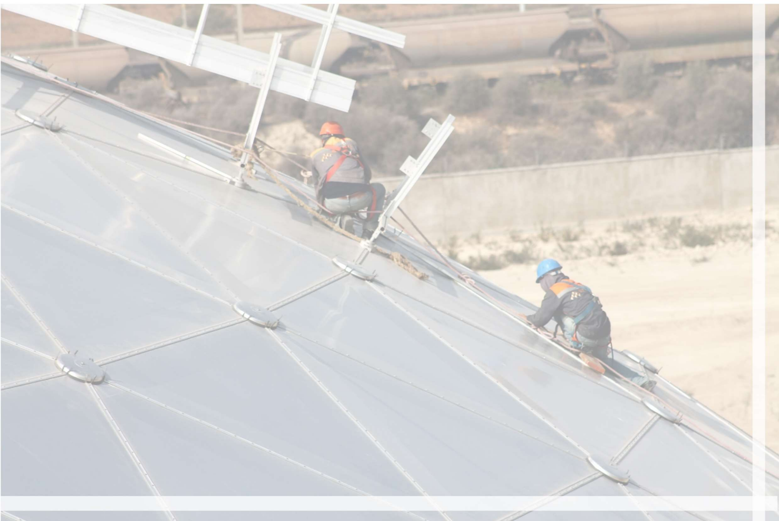
Montage d'un toit en aluminium Vacono©, dépôt pétrolier à Jorf Lasfar, STROC Industrie 2022
